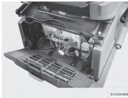
Fig. 98 Ubicazione centralina elettrica (Fiat/Citroën)
